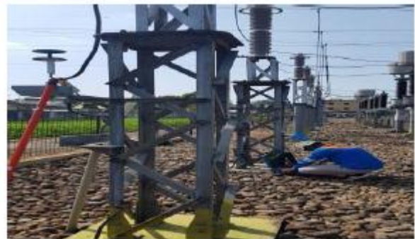
Gambar 3.2. Pengujian arus bocor pada arrester menggunakan Doble 500
