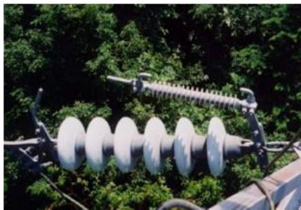
Gambar 2.3 Arrester dengan housing porselen (kiri) dan housing polymer (kanan)
