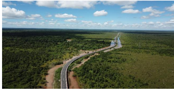
Gambar 2 Foto kondisi Pile Slab Tumbang Nusa Sumber: Olahan Peneliti, 2022
