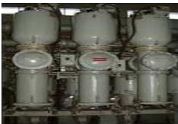
Gambar 2.3 Gambar isolasi gas sebagai isolasi
