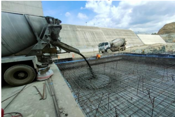
Gambar 9 Pengecoran Dengan Truck Mixer
