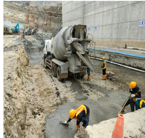
Gambar 3 Pekerjaan Lantai Kerja
