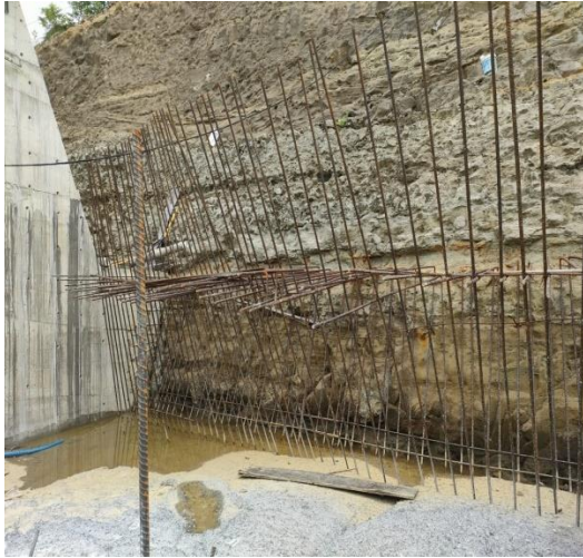
Gambar 5 Besi Tulangan bendungan
