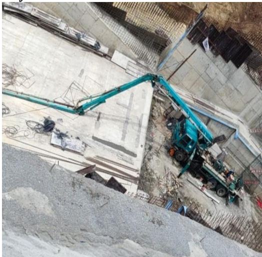
Gambar 10 Pengecoran dengan Concrete Pump
