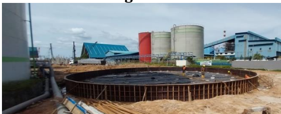
Gambar 6 : Bekisting dan pembesian
