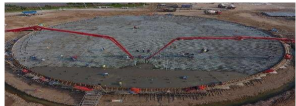
Gambar 10: Pengecoran Pondasi Tangki
