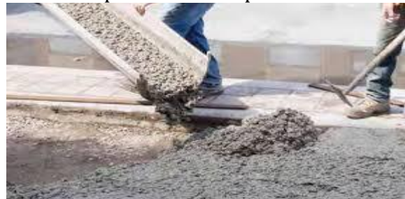
Gambar 8: Pengecoran Pondasi Tangki
