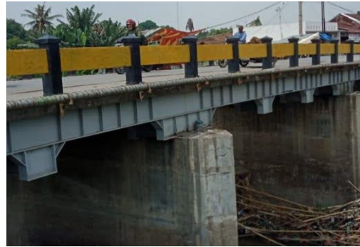
Gambar 3.2. Jembatan Titi Payung Hambaran Perak
