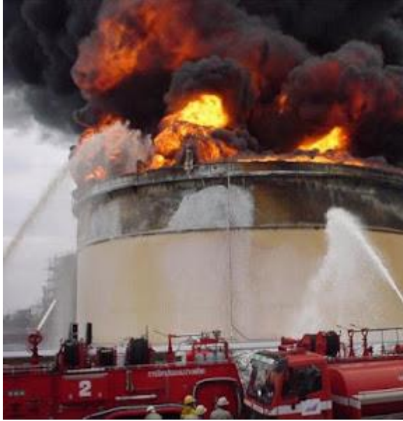
Gambar 2.1. Kebakaran Bejana Tekan
