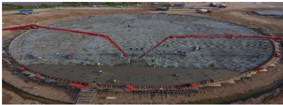
Gambar 10: Pengecoran Pondasi Tangki
