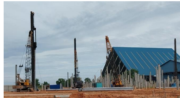
Gambar 4: Pemancangan Pile dengan Hammer
