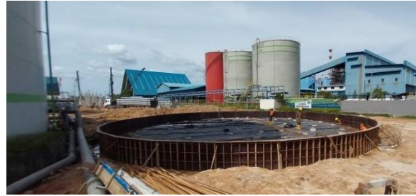
Gambar 6 : Bekisting dan pembesian
