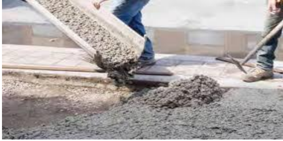
Gambar 8: Pengecoran Pondasi Tangki
