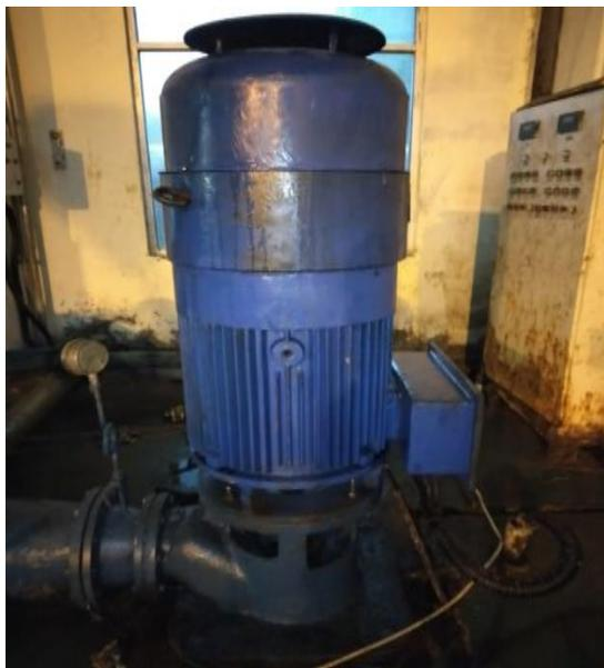
Gambar 2.3 Pompa Sentrifugal
